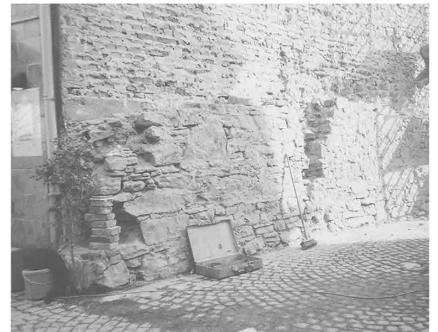
Die Mauer während der Sanierung 1998.
